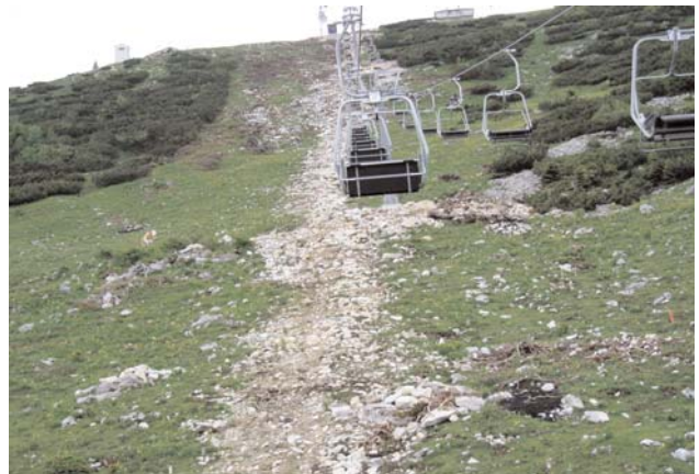
Abbildung 1: Beispiel für schlechte Rekultivierung im Bereich der Schipiste und des Kabelgrabens
